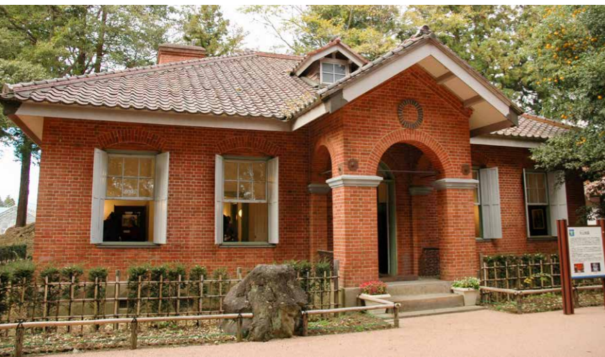
那須拓陽高校の敷地に建つ大山記念館。大山農場で焼いたレンガが、素朴で重厚な印象を醸し出している。
