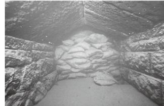
東隧道土質閉塞状況(東水門内側)
