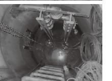
↑ 布類や水に溶けない紙などが巻き付いたポンプの吸込口 → 意外と知らないマンホールの内部
