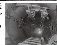
↑ 布類や水に溶けない紙などが巻き付いたポンプの吸込口 → 意外と知らないマンホールの内部
