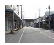
黒磯駅前の整備が順次スタートしています
