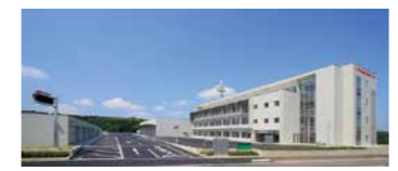
平成27年10月に統合した那須地区消防本部の庁舎(大田原市中田原)
