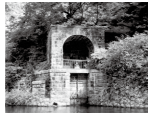
那須疏水旧取水口
