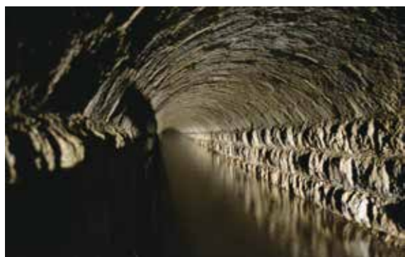
アーチ状の天井が特徴的な西隧道
