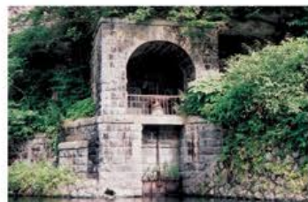
那須疎水旧取水施設(6区E-5)
