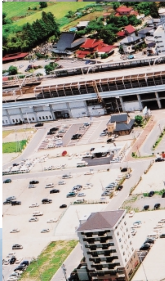
主要幹線道路となる国道4号
