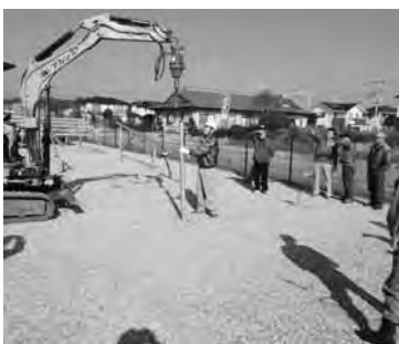
施工業者向け学習会での現場研修の様子
