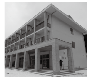
完成した新校舎
