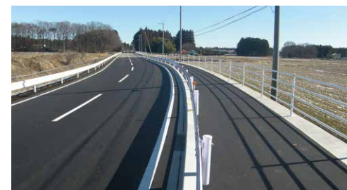
整備された歩道(洞島青木線)
