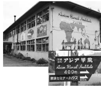
老朽化と震災被害で間もなく撤去される研修棟
