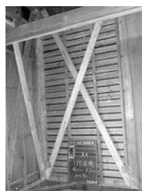
耐震改修工事の様子
