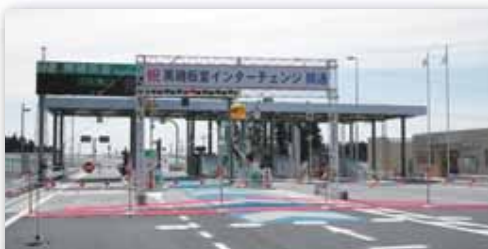
黒磯板室インターチェンジ開通
