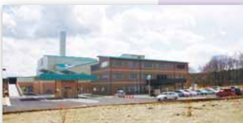
那須塩原クリーンセンター竣工
