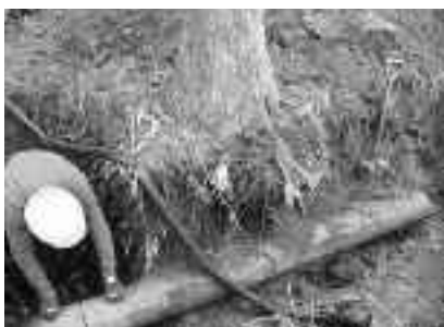
石綿セメント管の布設状況
