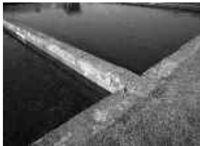
鳥野目浄水場 緩速ろ過池
