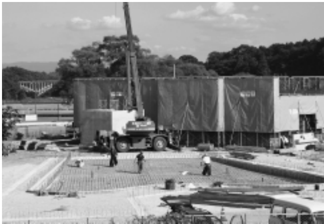
↑来夏のオープンに向け工事が進む那珂川河畔公園のプール
