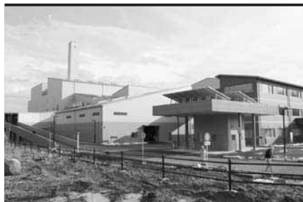
完成間近の那須塩原クリーンセンター
