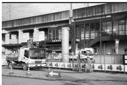
工事が進む JR 西那須野駅西口広場整備
