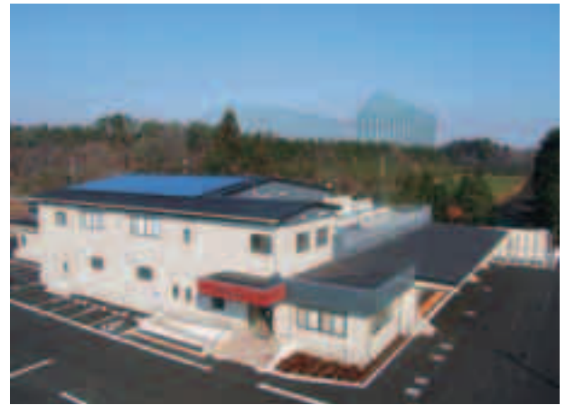
屋根の上に設置された太陽光パネル
