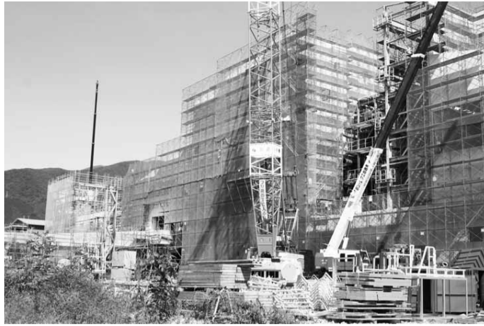
来年4月の稼働に向け、建設中の第2期ごみ処理施設
