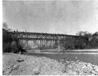
帳場格子 《晚翠橋の工事風景》1907年頃竣工
