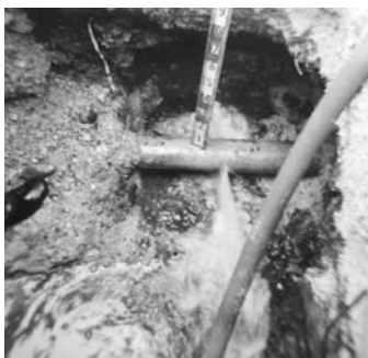
漏水している石綿セメント管
