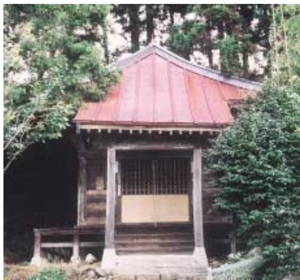
■所在地 金沢1137 平成5年(1993)市指定文化財《建造物》
