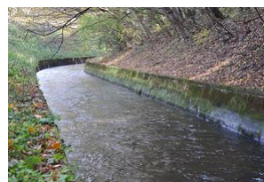
那須疏水本幹水路
