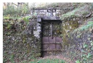
那須疏水旧取水施設 西水門
