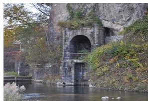
那須疏水旧取水施設 東水門
