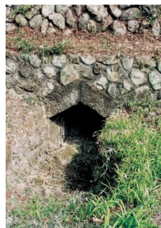
那須疏水旧蛇尾川伏越出口
