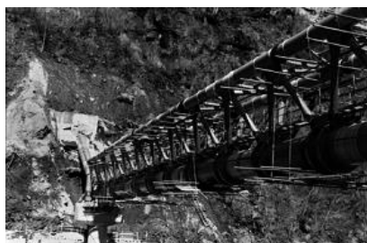
蛇尾川の水管橋の建設工事
