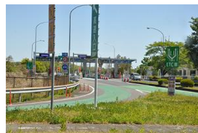
西那須野塩原インターチェンジ
