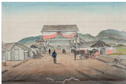
三島村の街道式場の様子 『三県道路完成記念帖』 (高橋由一作)より
