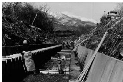
本幹水路の改修工事
