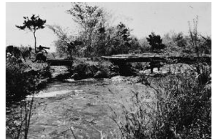
那須疏水第四分水堰
