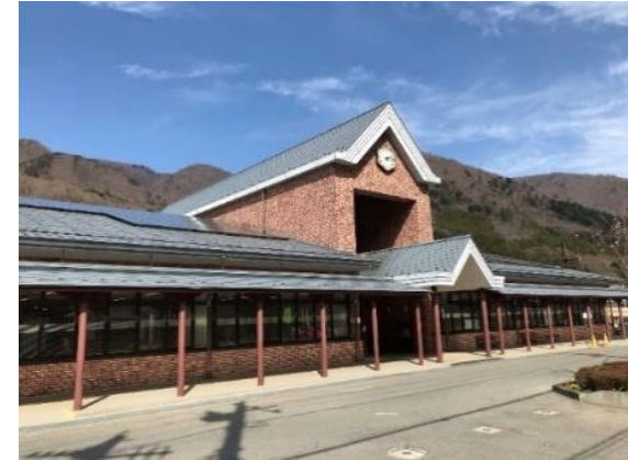
図2-6 市役所塩原庁舎の太陽光発電
