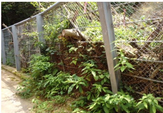
(鳴内山配水池)
