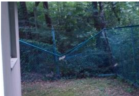
(青木第2配水池)
