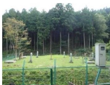
金沢下配水池
