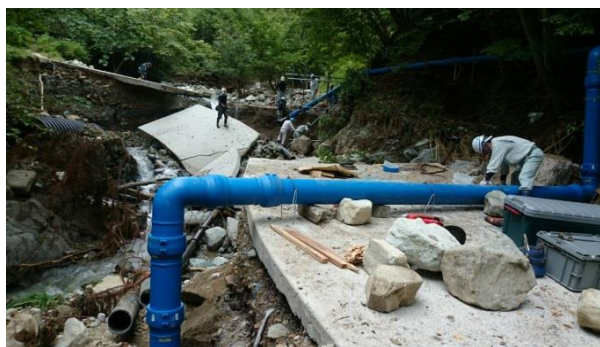
(復旧工事の様子)
