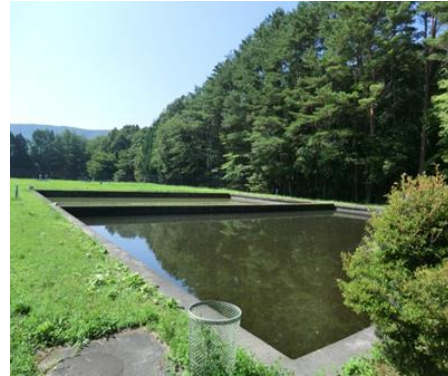
緩速ろ過（要害浄水場）
