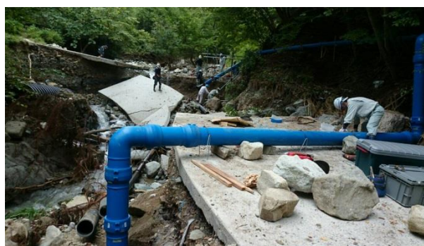
(復旧工事の様子)
