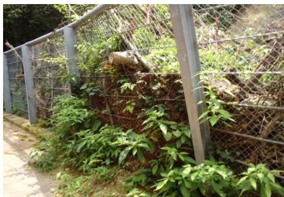
(鳴内山配水池)
