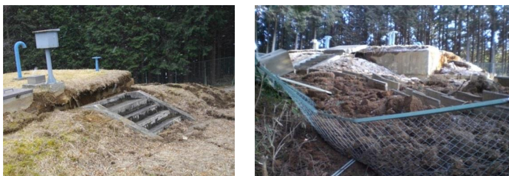
(熊久保配水池)
