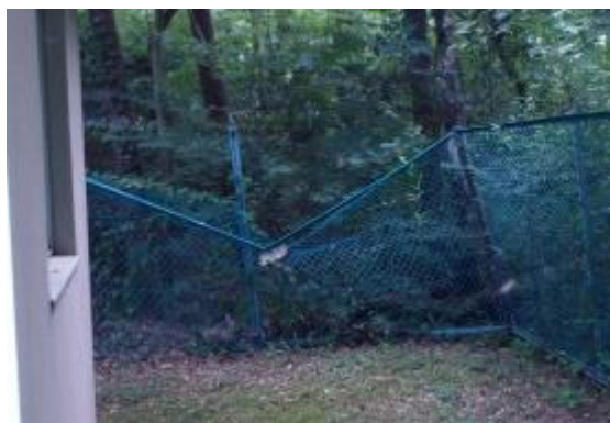
(青木第2配水池)
