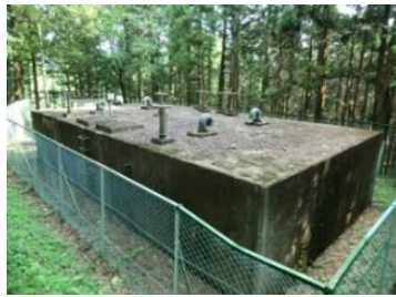
宇都野配水池
