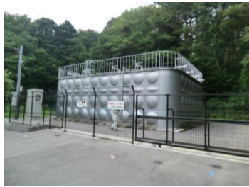
板室本村低区配水池
