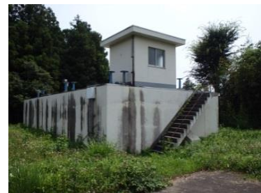
高林第 2 配水池
