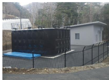
塩の湯ポンプ場
