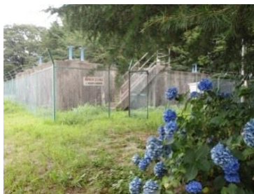
穴沢第 1 配水池
