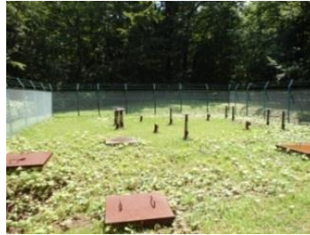
新湯第2配水池
