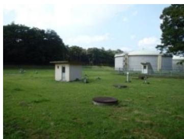
北那須配水池
