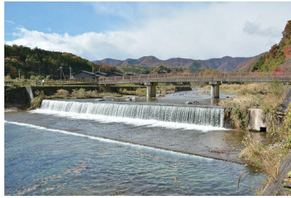
箒川要害公園付近
