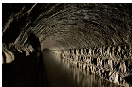
那須疏水（西隧道）
