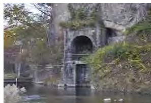
那須疏水旧取水施設 東水門
