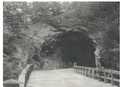
塩原新道「白雲洞トンネル」
