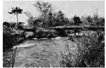
那須疏水第四分水堰
