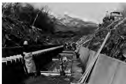
本幹水路の改修工事
