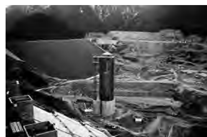
深山ダムの建設
