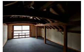
▲屋根裏部屋 和小屋という伝統的な日本建築の工法が用いられている。
