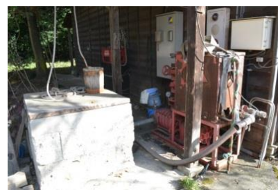
乃木希典那須野旧宅敷地内の 覆い屋付井戸及び揚水ポンプ
