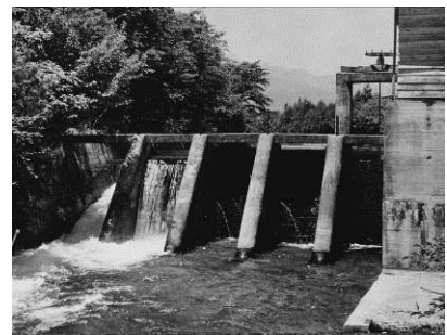
旧青木発電所（小水力発電）
