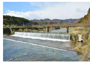
箒川要害公園付近
