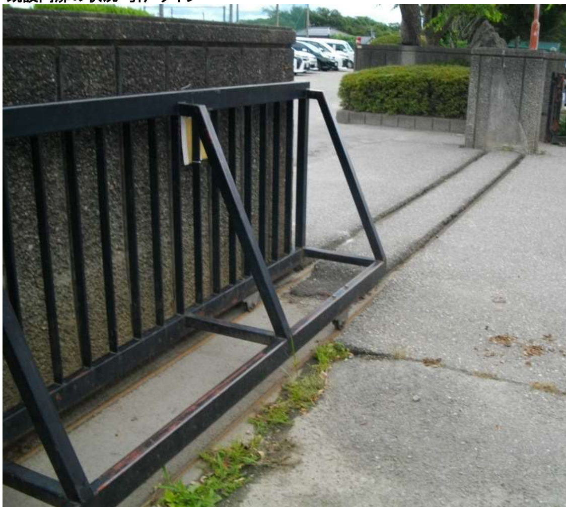
既設門扉の状況:引戸タイプ
