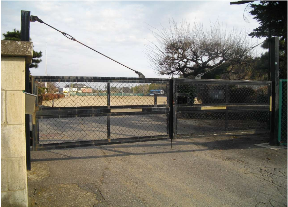
既設門扉の状況:両開きタイプ
