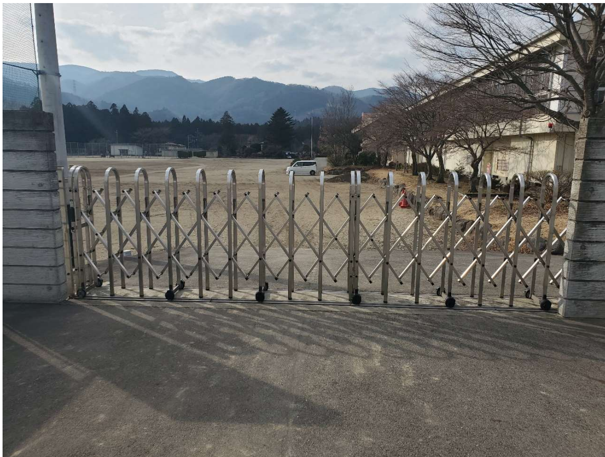
既設門扉の状況:アコーディオンタイプ
