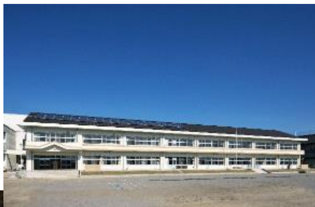
屋根に太陽光発電設備を設置した 西那須野中学校(平成26年度改築)
