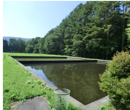
緩速ろ過（要害浄水場）
