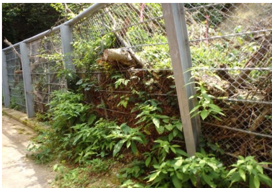
(鳴内山配水池)
