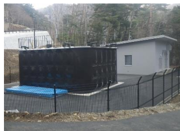
塩の湯ポンプ場
