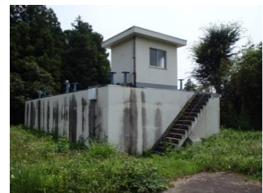
高林第2配水池
