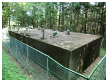
宇都野配水池
