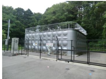
板室本村低区配水池
