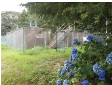
穴沢第1配水池
