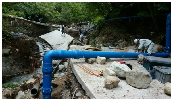
(復旧工事の様子)
