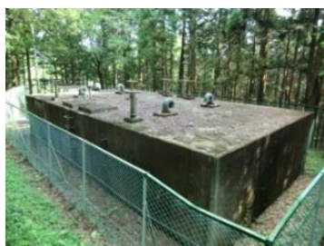
宇都野配水池
