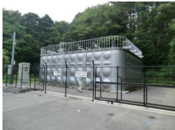
板室本村低区配水池
