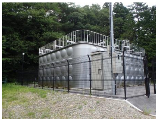
(板室本村低区配水池)
