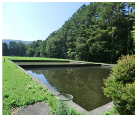
緩速ろ過（要害浄水場）
