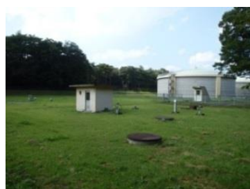
北那須配水池
