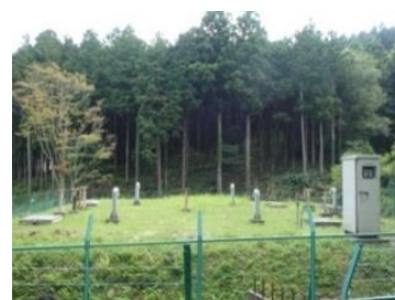
金沢下配水池
