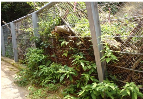
(鳴内山配水池)
