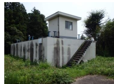
高林第 2 配水池
