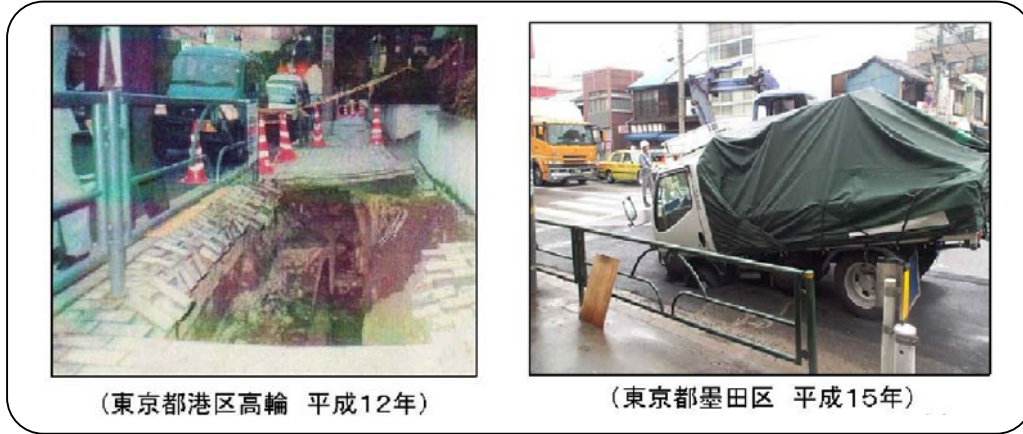
図 1-5 下水道管渠施設の劣化が原因となった道路陥没事故の例 (出典：国土交通省下水道部)
