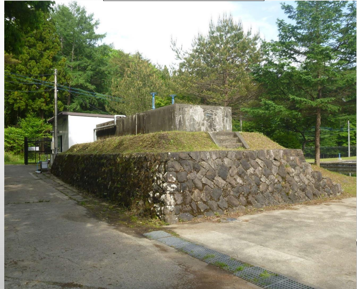
着水井(昭和44年竣工)
