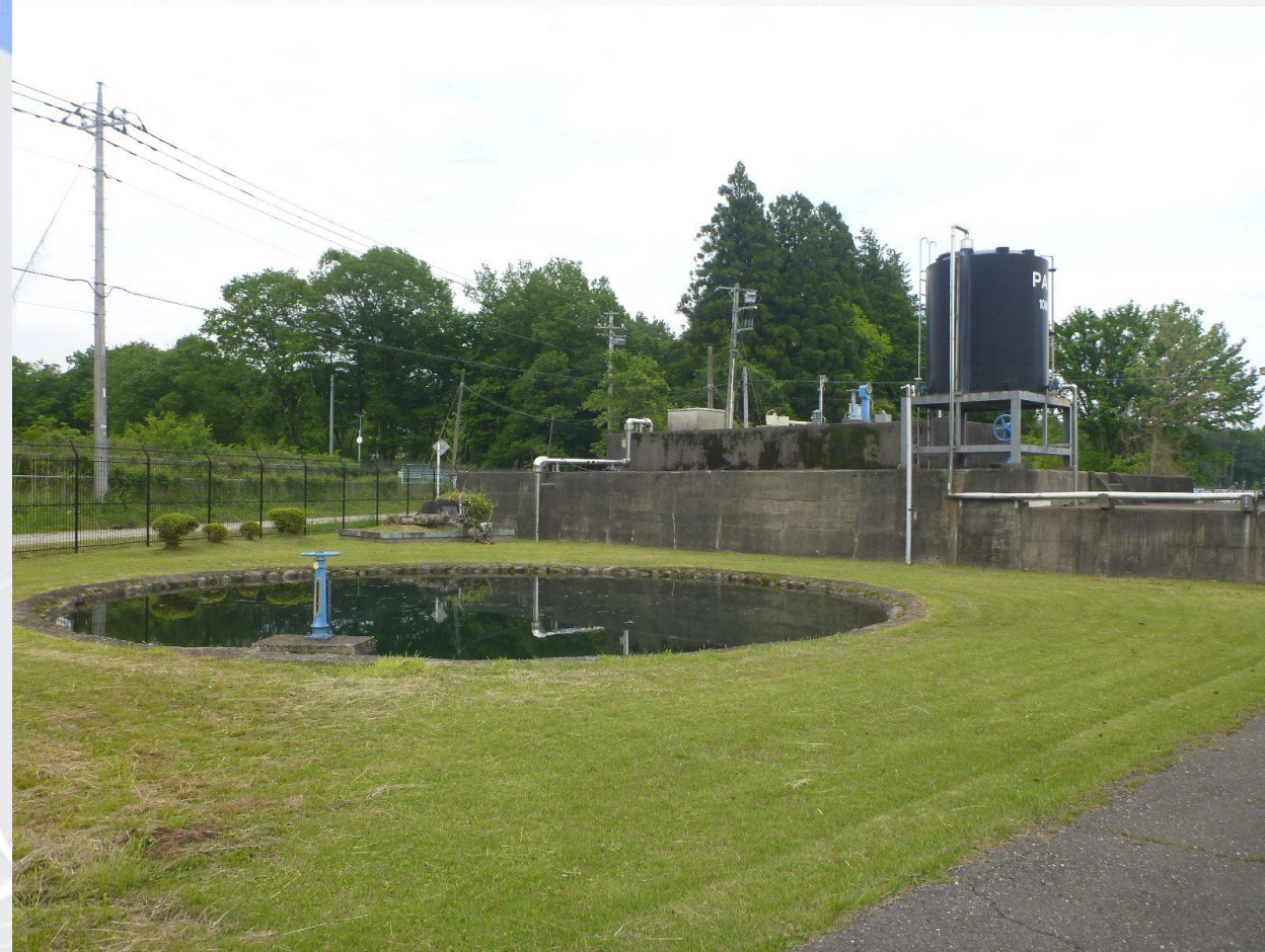
着水井(昭和48年竣工)
