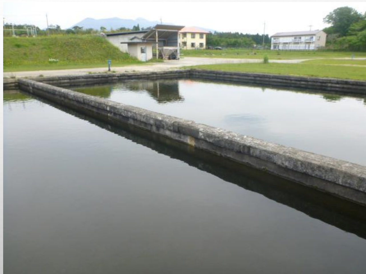
緩速ろ過池(昭和9年竣工)
