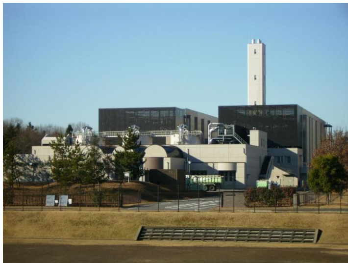
栃木県下水道資源化工場
