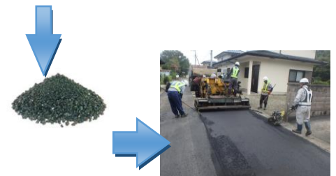
精製したスラグを工事で利用
