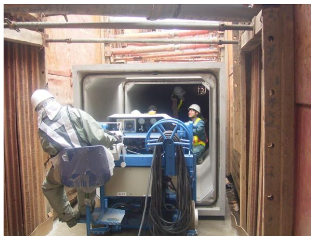
雨水幹線工事の実施状況
