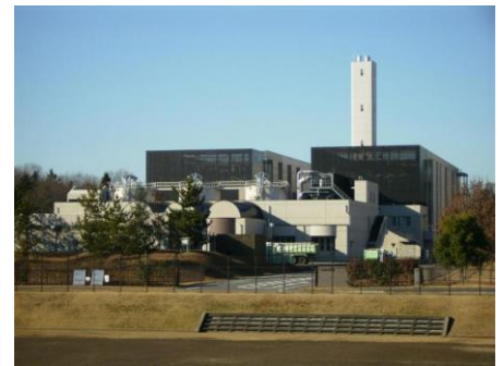
栃木県下水道資源化工場
