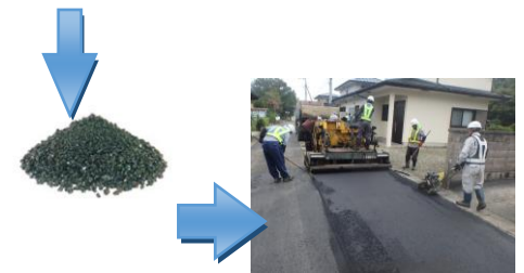
精製したスラグを工事で利用
