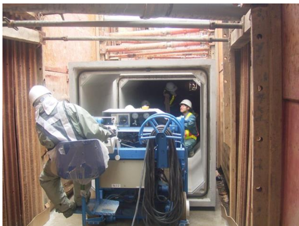
雨水幹線工事の実施状況
