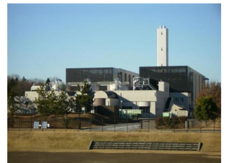
栃木県下水道資源化工場
