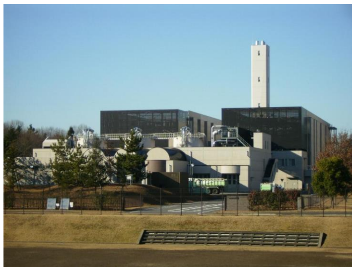
栃木県下水道資源化工場
