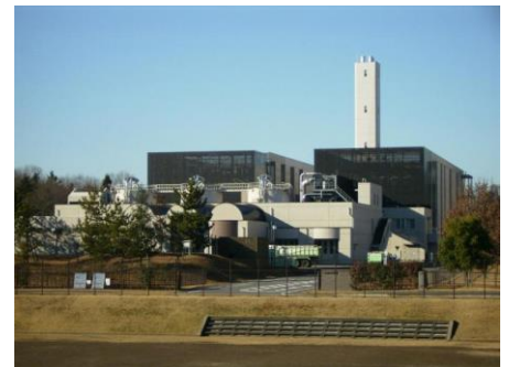
栃木県下水道資源化工場
