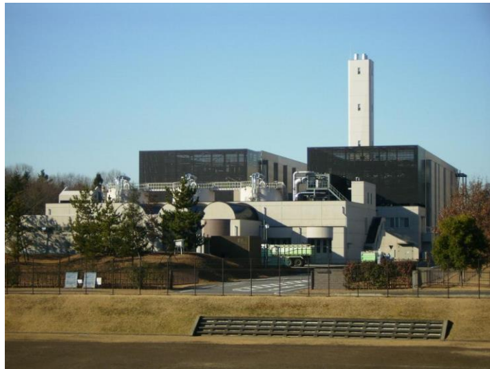
栃木県下水道資源化工場
