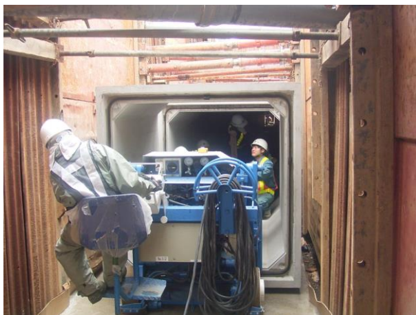
雨水幹線工事の実施状況
